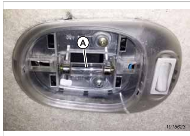
Abbildung 5.200: Deckenlicht in der Fahrerkabine mit abgenommener Abdeckung
